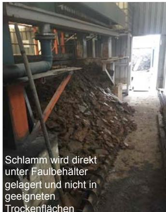
Schlamm wird direkt unter Faulbehälter gelagert und nicht in geeigneten Trockenflächen
